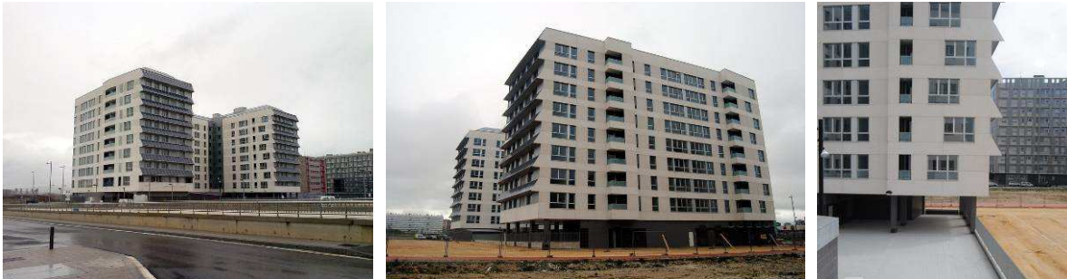
Figura 1: Diferentes vistas del edificio de 176 viviendas sociales terminado.
