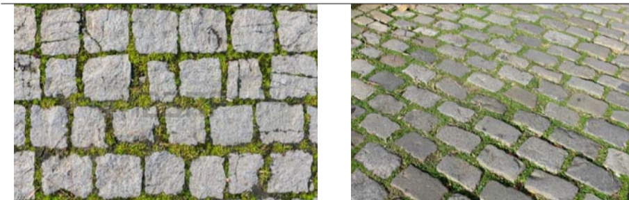
Zonas de estancia Pavimento ecológico adoquín de granito rellena de sustrato fértil donde sembrar cesped
