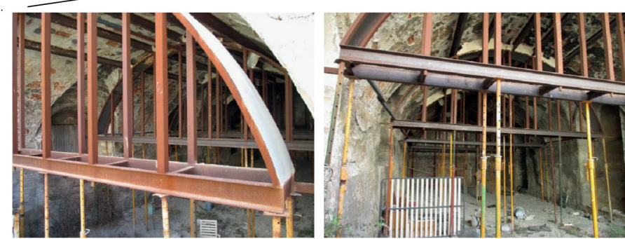
SUBJECCIÓN Y ANCLAJE DE BÓVEDA CON PERFILES METÁLICOS ANCLAJES Y PUNTALES
