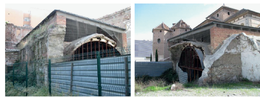
CUBRICIÓN DE CHAPA SOBRE VIGAS METÁLICAS
