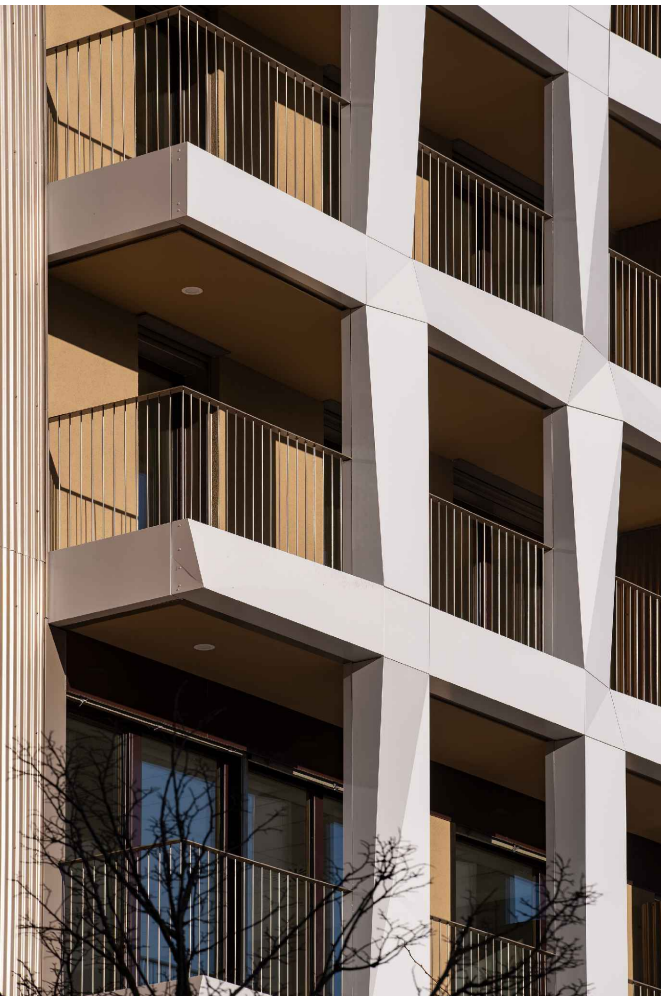
DETALLE DE FACHADA
