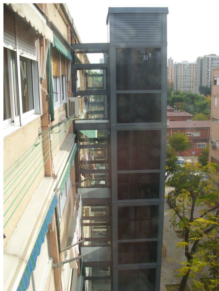
MURET, 4-6 DESDE MURET, 8
