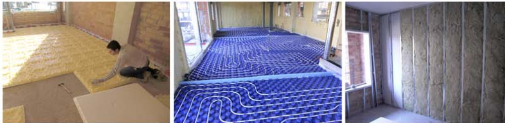
SUELO RADIANTE - DIVISORIAS EN SECO
