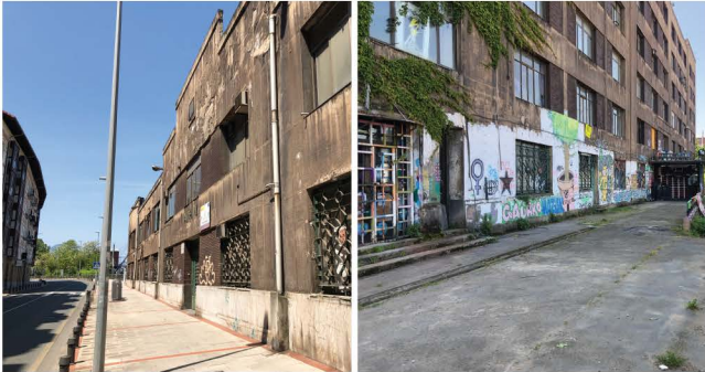
Fachada principal del edificio (SO) Entrada a nivel de calle en Planta 0
