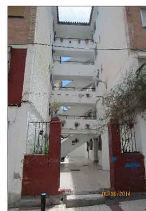
Foto 4. Acceso a edificio
